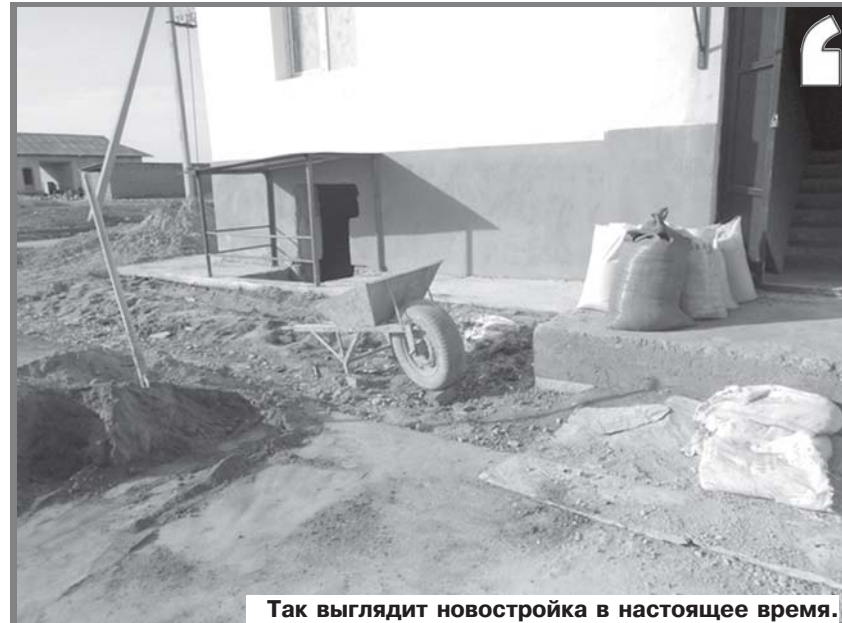
Так выглядит новостройка в настоящее время.
